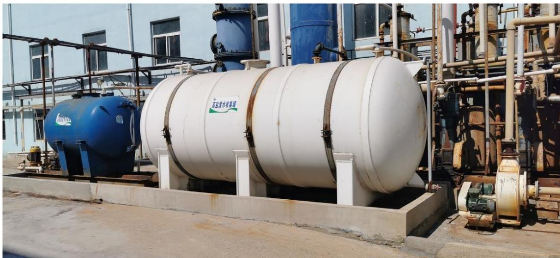
图 4-25 五车间南侧高盐废水收集管及生产装置
